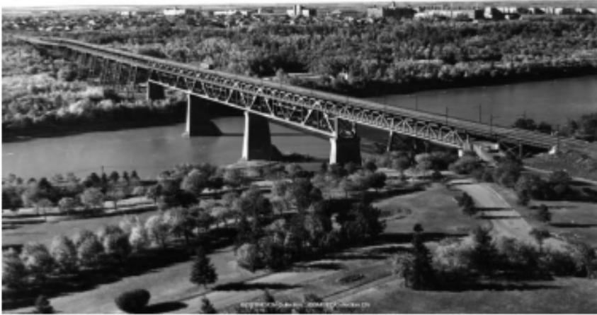
Pont à poutre High Level- construit 1913. Edmonton, Alberta. Rivière North Saskatchewan
